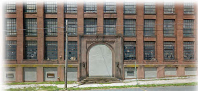
Kreider Commons before Renovation
