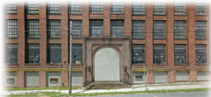
Kreider Commons Before Renovation
